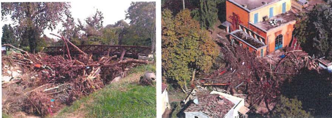
Passerelle du Golf
