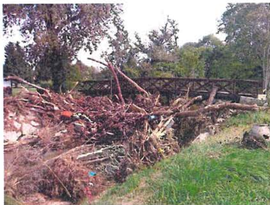
Passerelle du Golf
